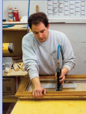
Vitrage sur tables à dépression et pose des parclozes sur menuiseries bois en clouage "invisible".
